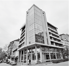
事務所が入居するビル
